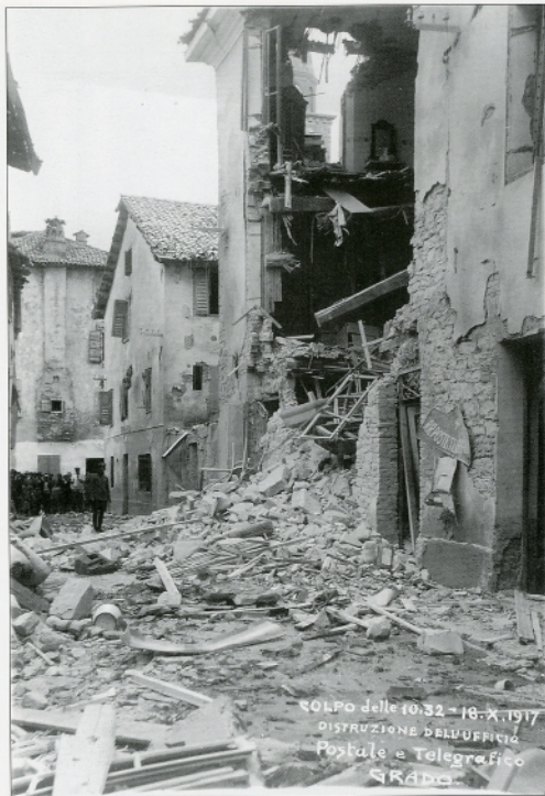
Colpo delle 10.32 - 18 X 1917. Distruzione dell'Ufficio Postale e Telegrafico. Grado. MCRR Ved 13a(21)
